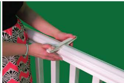
Snap brackets on railing Soportes de fijacion en la barandilla
