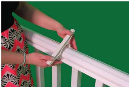
Place brackets on railing Coloque los soportes en la barandilla
